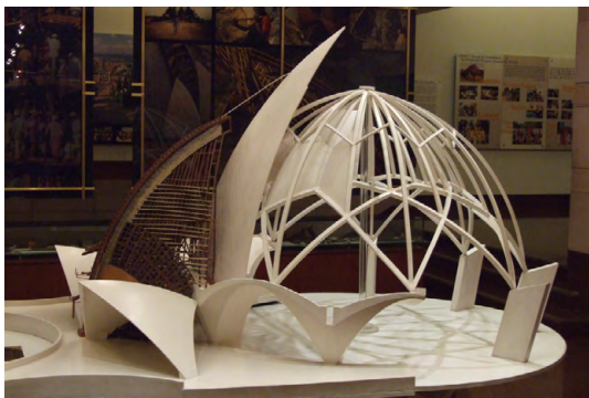
ماکتی از سازه بنا. هسته دایره‌شکل بنا و طرز سوار شدن گلبرگ‌ها در این‌جا مشخص است. تصویر از (Architexturez) ۱
